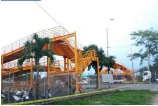
Puente Peatonal ubicado Vía Cali - Jamundí
